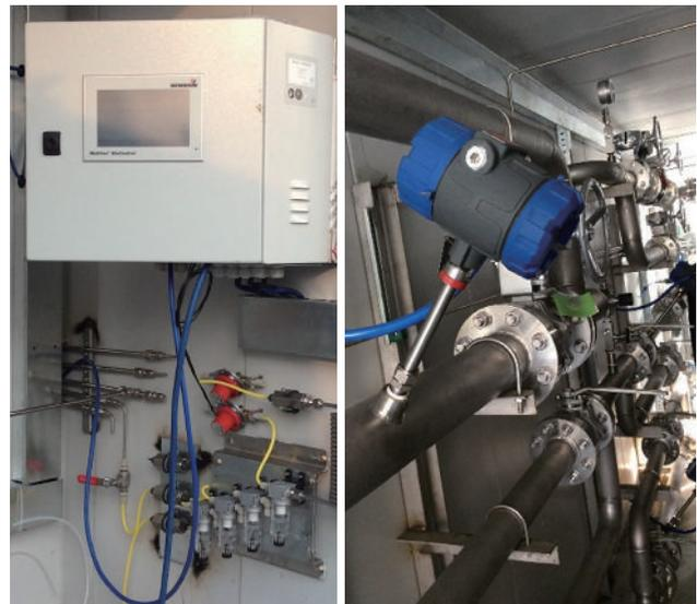
Installierte Geräte-Kombination aus stationärer Einheit und mobilem Mehrgasmessgerät (links); integrierter Durchfluss- und Temperaturtransmitter (rechts)
