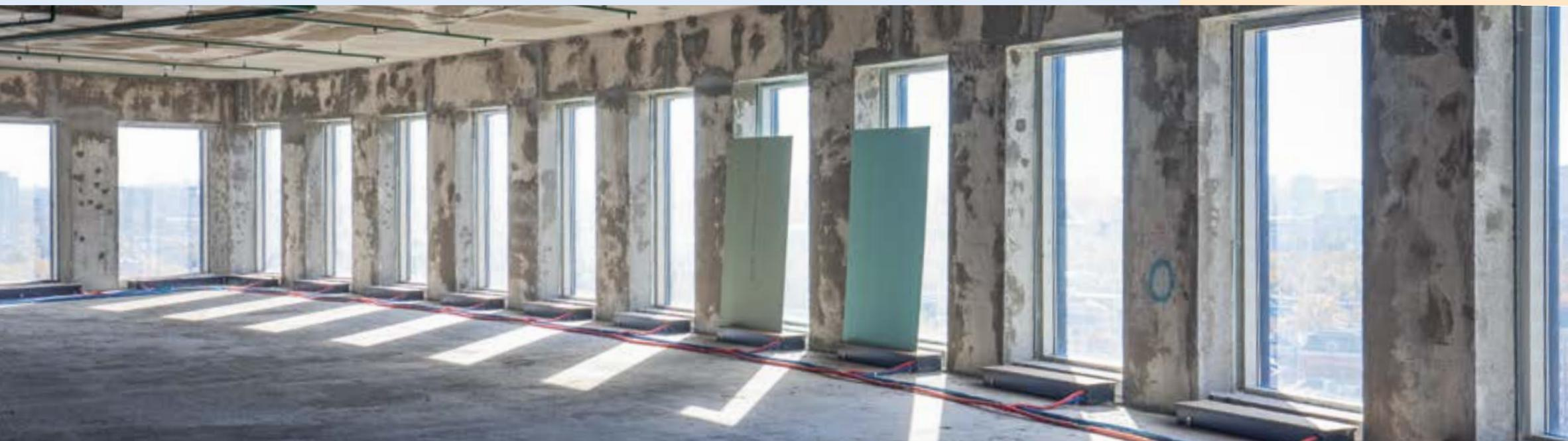
Blanker Beton und Panoramafenster: Der Innenausbau beginnt in der ersten Oktoberwoche 2018. Lediglich die Heizungsleitungen sind verlegt.
