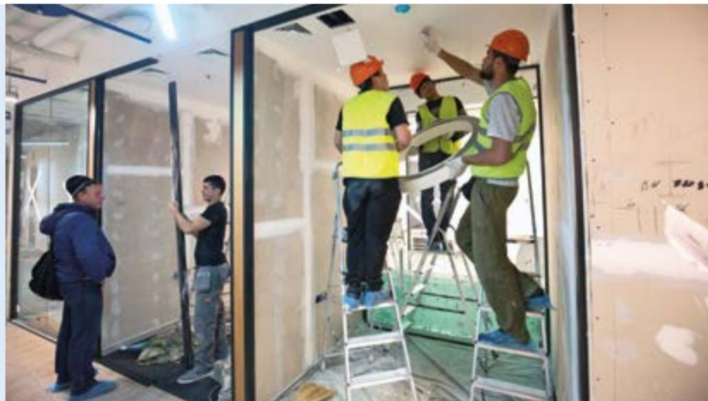
▲ Mitte Dezember, zwei Wochen vor der geplanten Deadline, geht der Innenausbau in die Endphase. Glaswände für die Besprechungsräume werden montiert, die Klimaanlage getestet. Foto: Jewgeni Kondakow.
