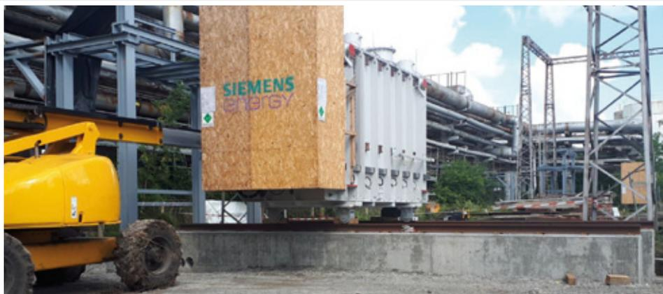
Siemens Energy Основно тяло на силов трансформатор 110 kV 63 MVA на площадка за сглобяване
