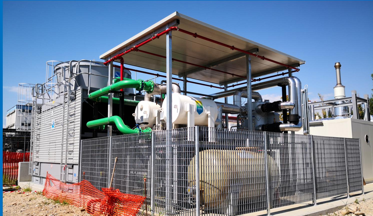
L'impianto è composto da un impianto di cogenerazione containerizzato con motore endotermico alimentato a gas.
