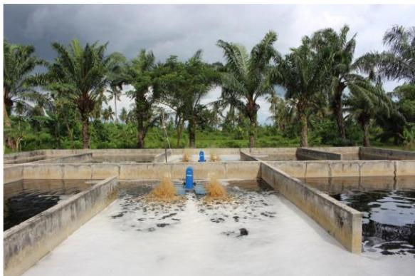
Abbildung 6: Sickerwasserbehandlungsanlage auf der TPA Banjar Basirih
